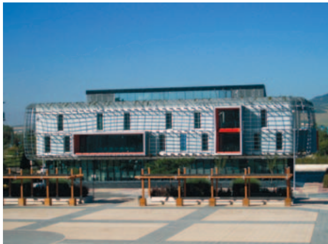
Edificio bioclimático del Ayuntamiento de Noain (Navarra).
